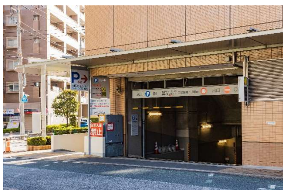
【駐車場（地下）入口】
