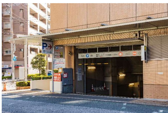
【駐車場（地下）入口】
