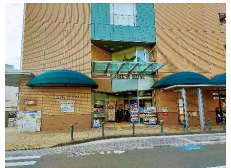
【南側正面出入口】
