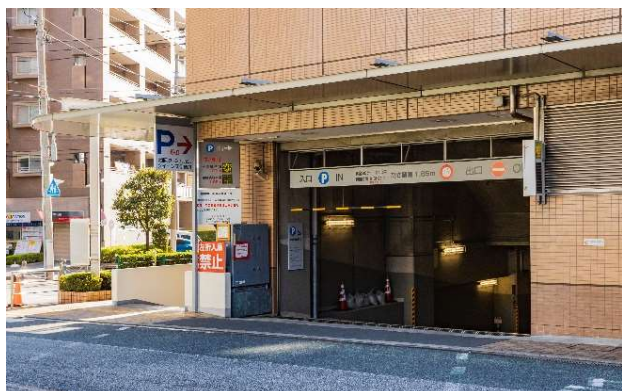
【駐車場（地下）入口】
